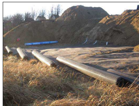
Foto 2. Instalación primera capa de BX-1200
