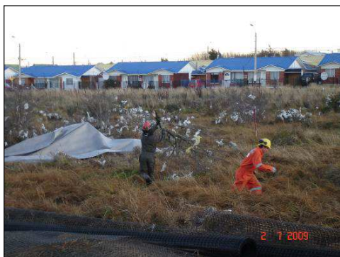
Foto 1. Preparación del terreno
