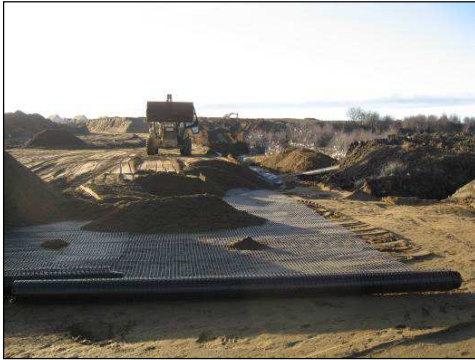
Foto 3. Instalación segunda capa de BX 1200 TENSAR Foto 4. Instalación geotextil estabilizador de suelos
