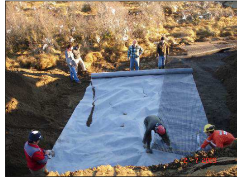
Foto 3. Instalación segunda capa de BX 1200 TENSAR Foto 4. Instalación geotextil estabilizador de suelos
